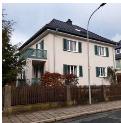
Die prämierte Sanierung der Fassade in der Lutherstraße 13
