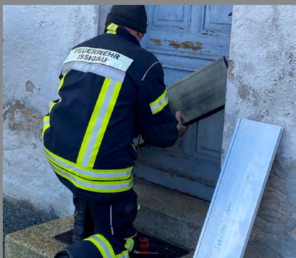
Anbringung eines Schotts
